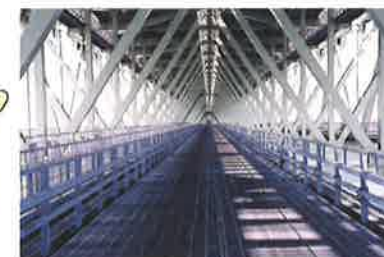
橋桁内の管理路
